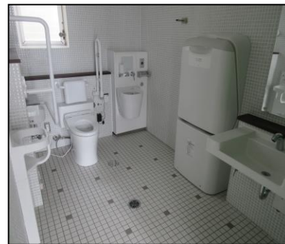
多機能トイレの設置
