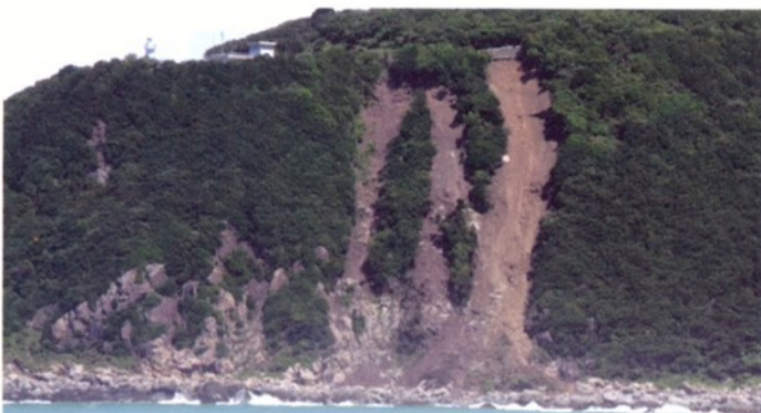
▲日ノ御崎周辺の崩落現場
