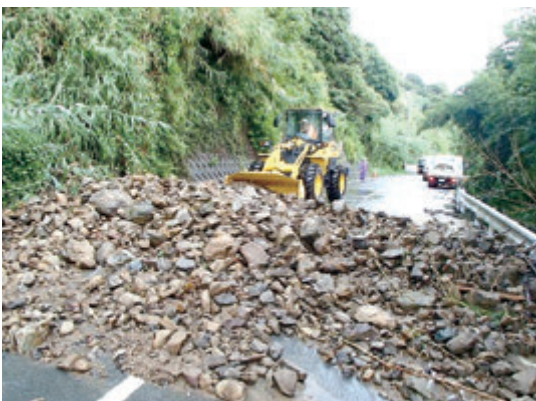
▲ 平成28年9月20日 台風16号降雨による土石流
