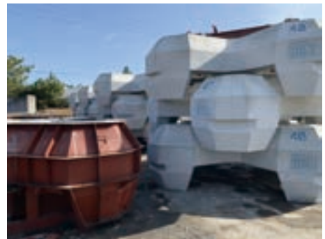
▲ ブロックの製作が進む
