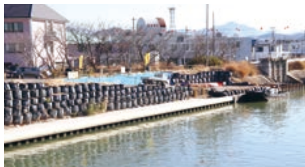
▲ 西川護岸整備事業
