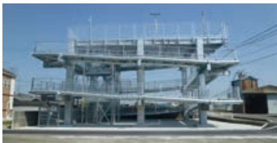
▲ 浜ノ瀬避難タワー
