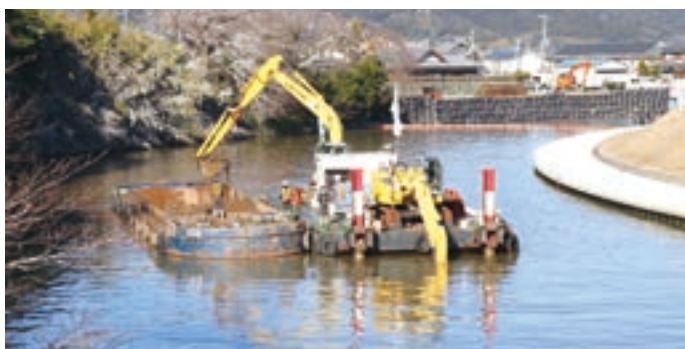
▲ 西川浚渫事業
