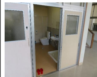
段差を解消したトイレ
