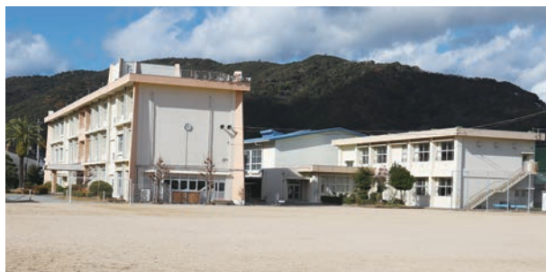
▲ 和田小学校 (昭和44年建築)
