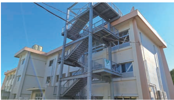
▲ 和田小学校の外付け階段
