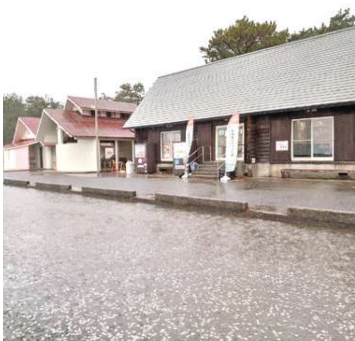
▲水はけの悪い管理棟前の道路
