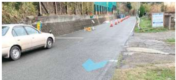
▲のり面改修中の三尾海岸線県道
